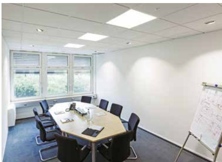
LED-Beleuchtungssystem, das den Strom ber Power over Ethernet Plus (PoE+) erhlt. Sensoren erfassen die momentane Beleuchtungsstrke und leiten sie an die IP-basierend Beleuchtungssteuerung weiter.
